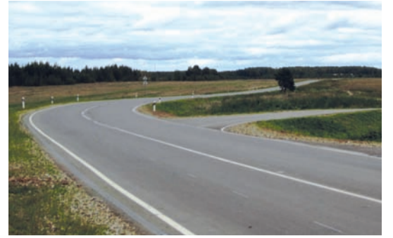
Автодорога «Вески – Крючково»
