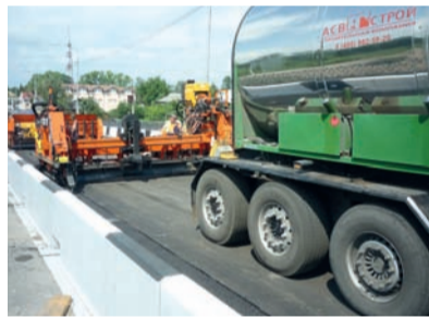
Устройство покрытия из литого асфальтобетона
