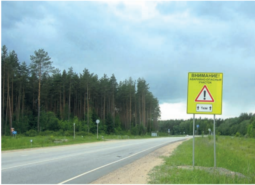
Автодорога «Тверь – Лотошино – Шаховская – Уваровка»
