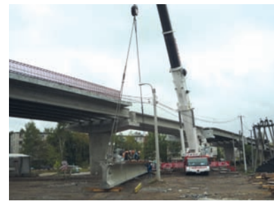
Монтаж балок пролетных строений
