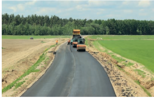
Капитальный ремонт автодороги «Дубровка – Городище»
